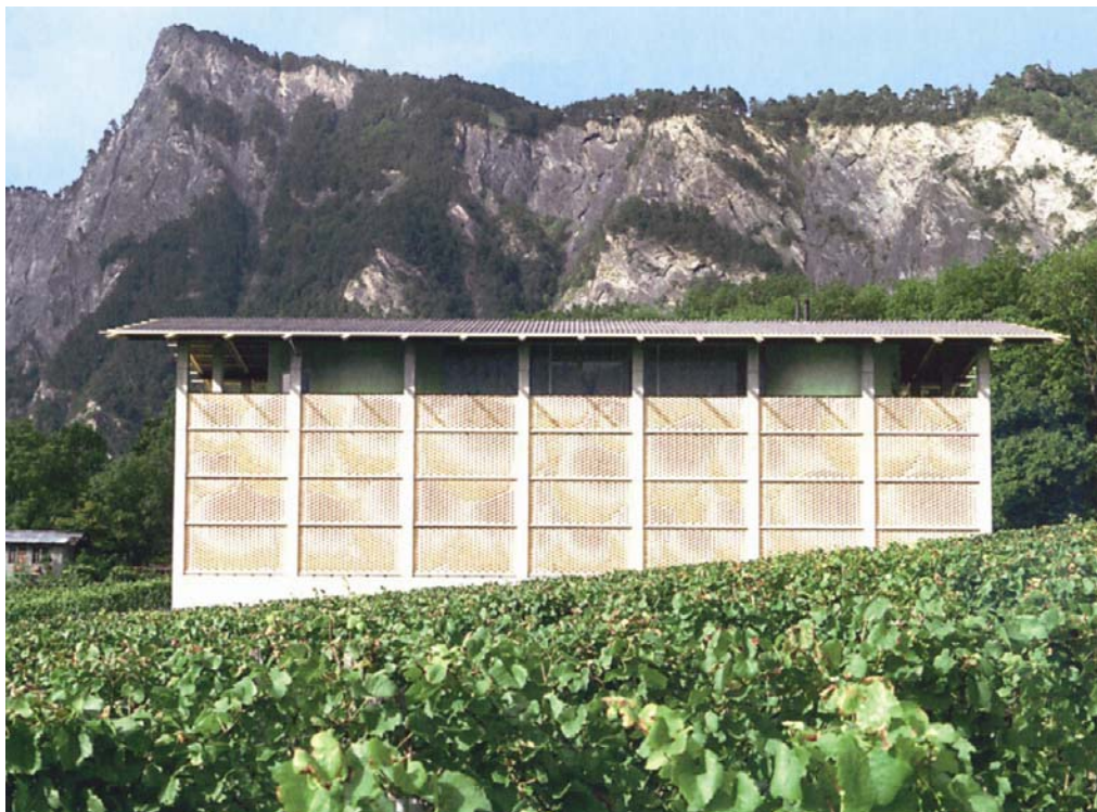
Pročeljni zid vinarije u Fläschu
